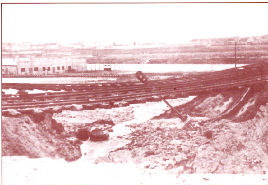
A Gubacsi híd felrobbantott feljárója, a sérült ivóvízvezetékéből ömlött a víz a Kis-Dunába 1956. november 6-án
